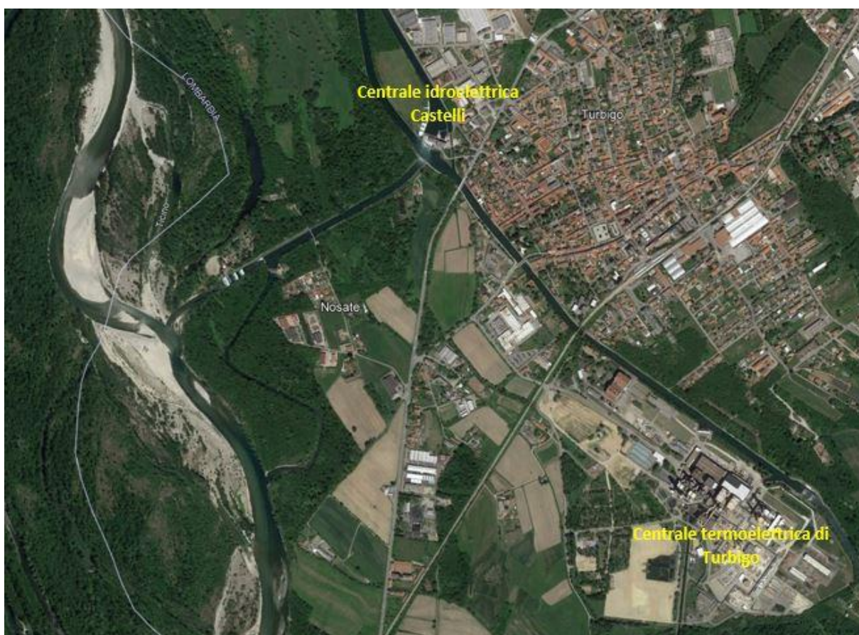
Figura 1 – Tratto di competenza IREN per interventi di manutenzione sul Canale Naviglio Grande.
