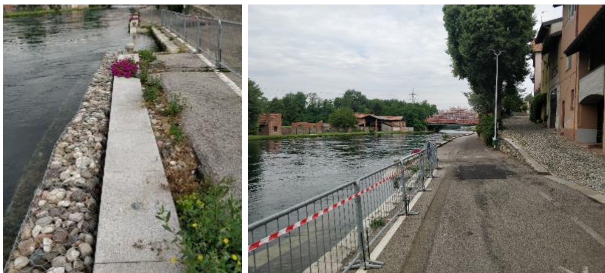
Figura 26 – Vista da valle del manufatto di approdo.
