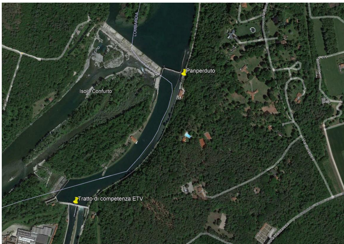
Figura 5 – Diga di Panperduto.
