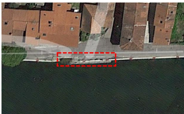
Figura 22 – Manufatto di approdo, soggetto a pregresso fenomeno di instabilità.
