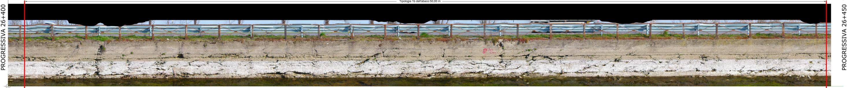
TIPOLOGIA 1a e 1b - Pulizia superfici in c/s mediante getto d'acqua a forte pressione. Ripristino delle strutture degradate in c/s mediante riempimento dei vuoti con malta cementizia tixotropica, fibrorinforzata con fibre sintetiche superficie in c/s mediante applicazione a spruzzo di malta cementizia tixotropica sp 2 cm fibrorinforzata con fibre sintetiche ed inerte al 30% 4-10 mm. Realizzazione di giunto di dilatazione 1x2 cm ogni 5 m. Formazione di rizzata di pr
