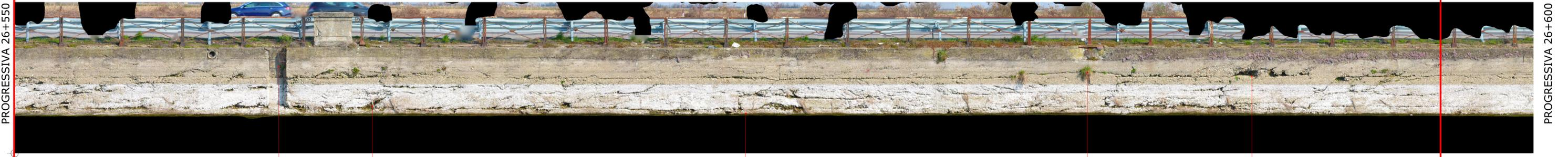
Rimozione scaletta esistente      Riempimento cavità con malta cementizia      Formazione di rizzata al piede      Rimozione vegetazione infestante      Riempimento cavità con malta cementizia
