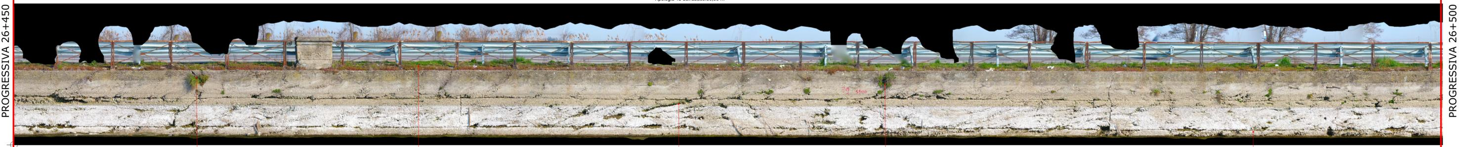
Mantenimento scoli esistenti      Rimozione vegetazione infestante      Riempimento cavità con malta cementizia      Mantenimento scoli esistenti      Formazione di rizzata al piede
