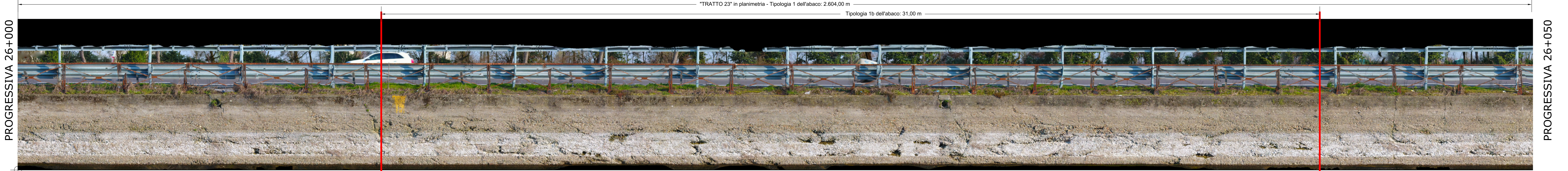
PROGRESSIVA 26+000 TRATTO 23" in planimetria - Tipologia 1 dell'abaco: 2.604,00 m Tipologia 1b dell'abaco: 31,00 m TIPOLOGIA 1a e 1b - Pulizia superfici in c/s mediante getto d'acqua a forte pressione. Ripristino delle strutture degradate in c/s mediante riempimento dei vuoti con malta cementizia tixotropica, fibrorinforzata con fibre sintetiche mediante applicazione a spruzzo di malta cementizia tixotropica sp 2 cm fibrorinforzata con fibre sintetiche ed inerte al 30% 4-10 mm. Realizzazione di giunto di dilatazione 1x2 cm ogni 5 m. Formazione di rizzata di protezione al piede
