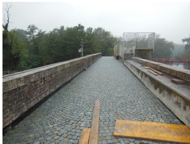
Foto 2: Completamento dei lavori presso l'incile del Canale Villorosi - 10.2014
