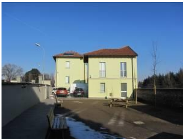
Foto 1: Fine intervento - Sistemazione esterna
