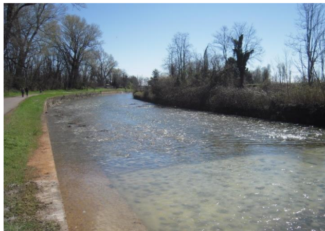
Foto 2: Interventi del lotto 2 a lavori ultimati
