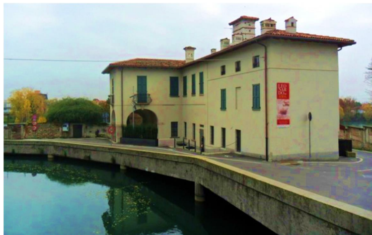
Foto 1: Casa del Custode delle Acque a Vaprio d'Adda
