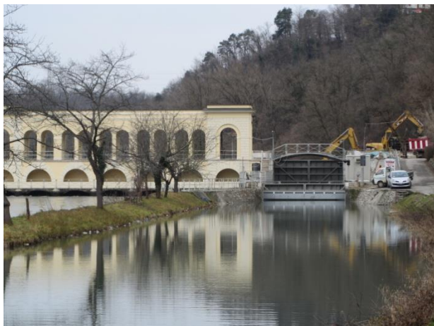
Foto 1: Rimozione della tura di valle, con immissione acqua nel canale di navigazione - 01.2015
