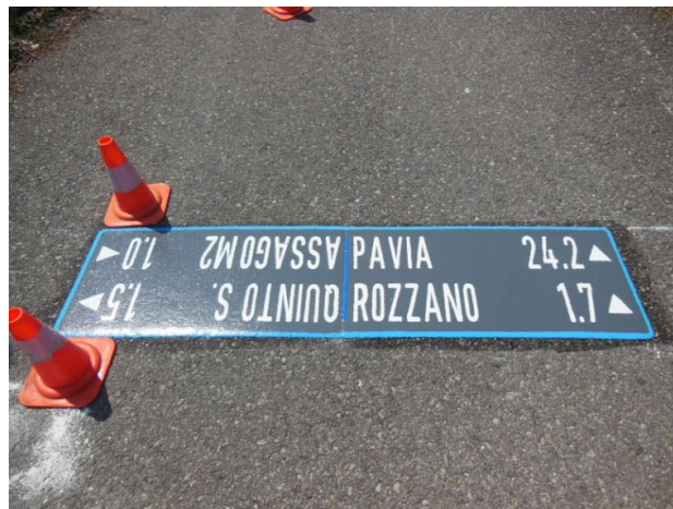
Foto 2 - Lavorazioni terminate per piastra direzionale
