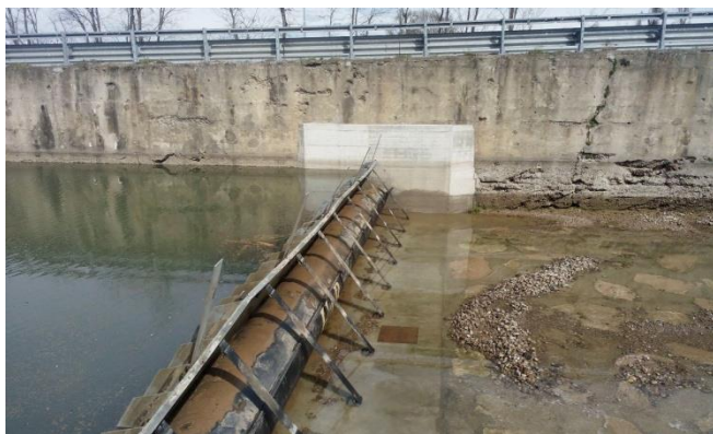
Foto 1: Prove di funzionalità della tura mobile all'interno dell'alveo del Naviglio Grande con acqua irrigua (prova tenuta invaso) - 30.03.2015
