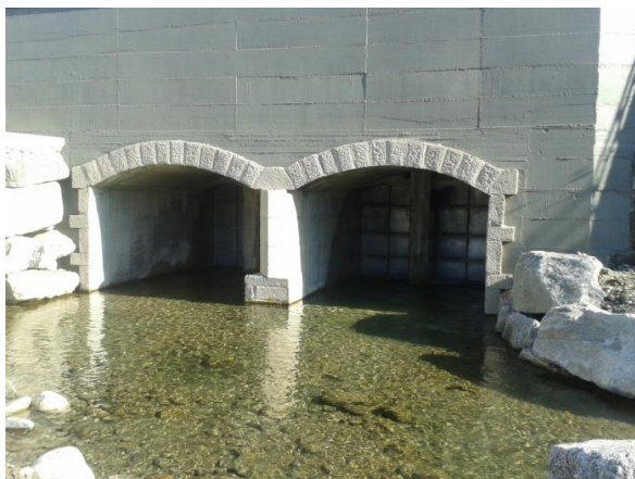
Foto 1: Completamento del manufatto portine della sabbia (I stralcio) - 05.11.2015
