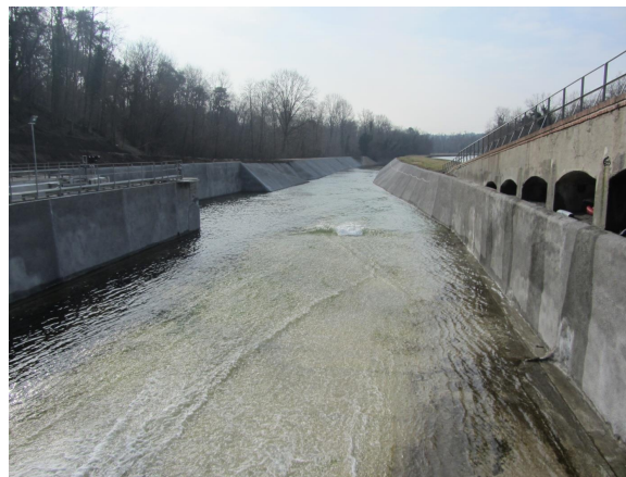
Foto 2: Rituzione nel tratto di canale al termine dei lavori - 18.02.2015
