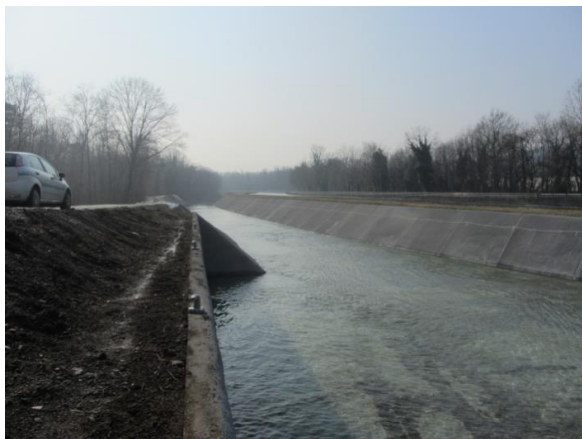
Foto 1: Ripristino ambientale e opere di finitura (bitte) presso il nuovo muro di sponda - 12.02. 2015
