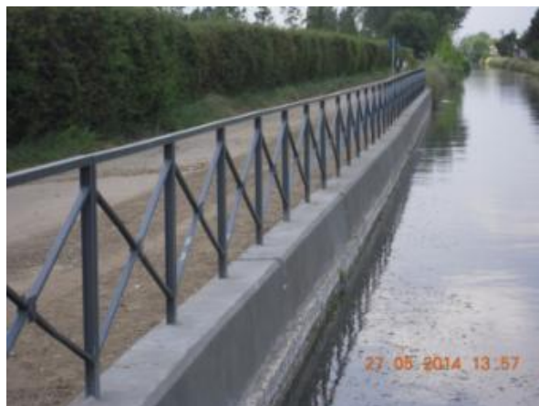
Foto 1: Intervento in Comune di Rozzano
