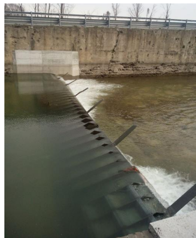
Foto 2: Prove di funzionalità della tura mobile all'interno dell'alveo del Naviglio Grande con acqua irrigua (fase di gonfiaggio con portata nel Naviglio di circa 10 mc/s) - 30.03.2015
