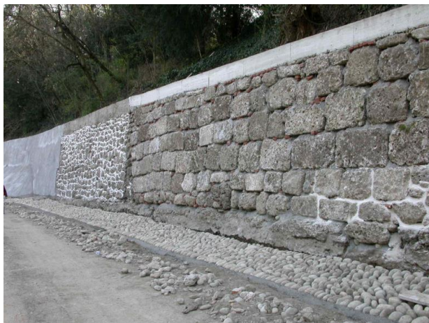
Foto 1: Intervento P.3 - Vaprio d'Adda
