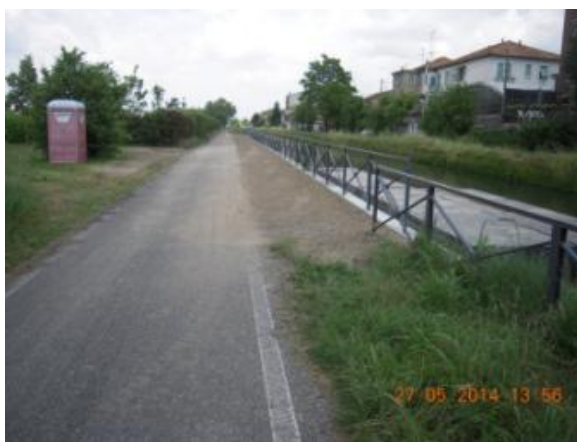
Foto 2: Intervento in Comune di Rozzano
