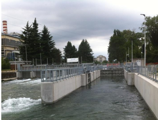
Foto 1: Diga di Poiret a lavori ultimati
