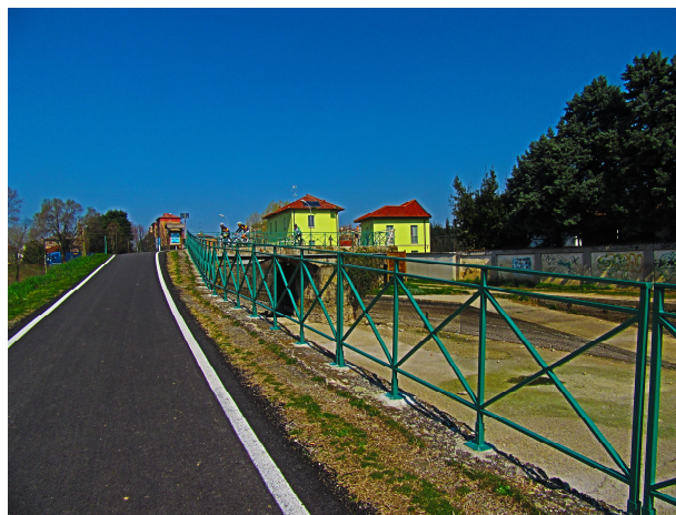
Foto 3: Naviglio di Bereguardo - ponte al Casello del dazio Abbiategrasso a lavori ultimati
