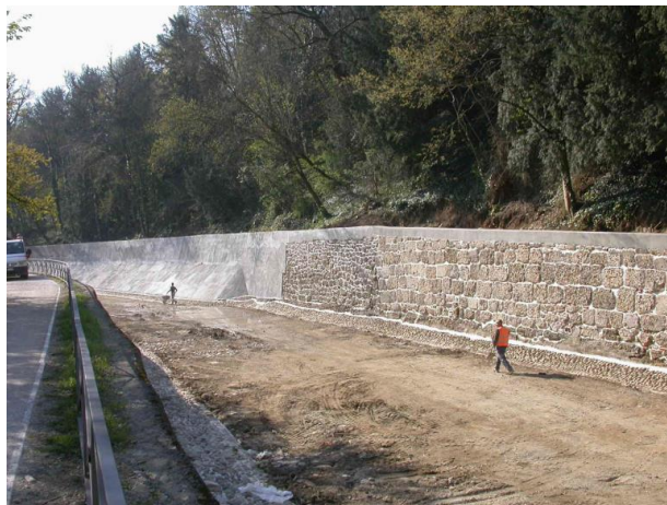
Foto 2: Intervento P.3 - Vaprio d'Adda
