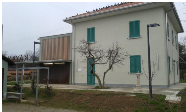
Foto 1: Fine lavori casello
