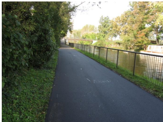
Foto 1: Naviglio Grande - nuovo asfalto in Comune di Cuggiono (MI) - 20.10.2015
