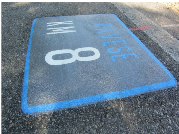
Foto 1 - Esempio di piastra posizionale posata
