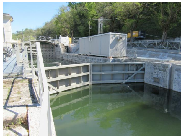
Foto 2: La conca vista da valle al termine delle lavorazioni - 02.2015
